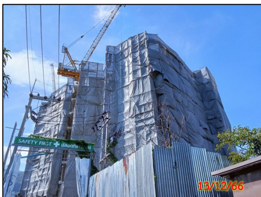
รูปที่ 2.2-3 ติดตั้งผ้าใบก่อสร้างครอบคลุมโดยรอบอาคารตั้งแต่ชั้นล่างจนถึงส่วนสูงสุดของอาคาร
